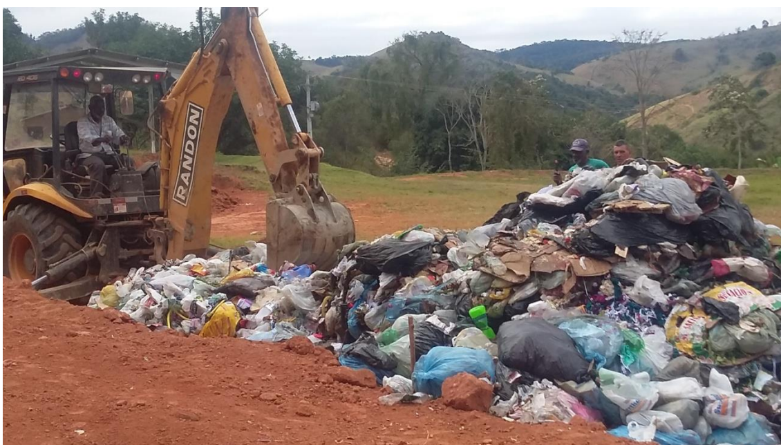
Figura 22: Espalhamento dos resíduos com retroescavadeira.
