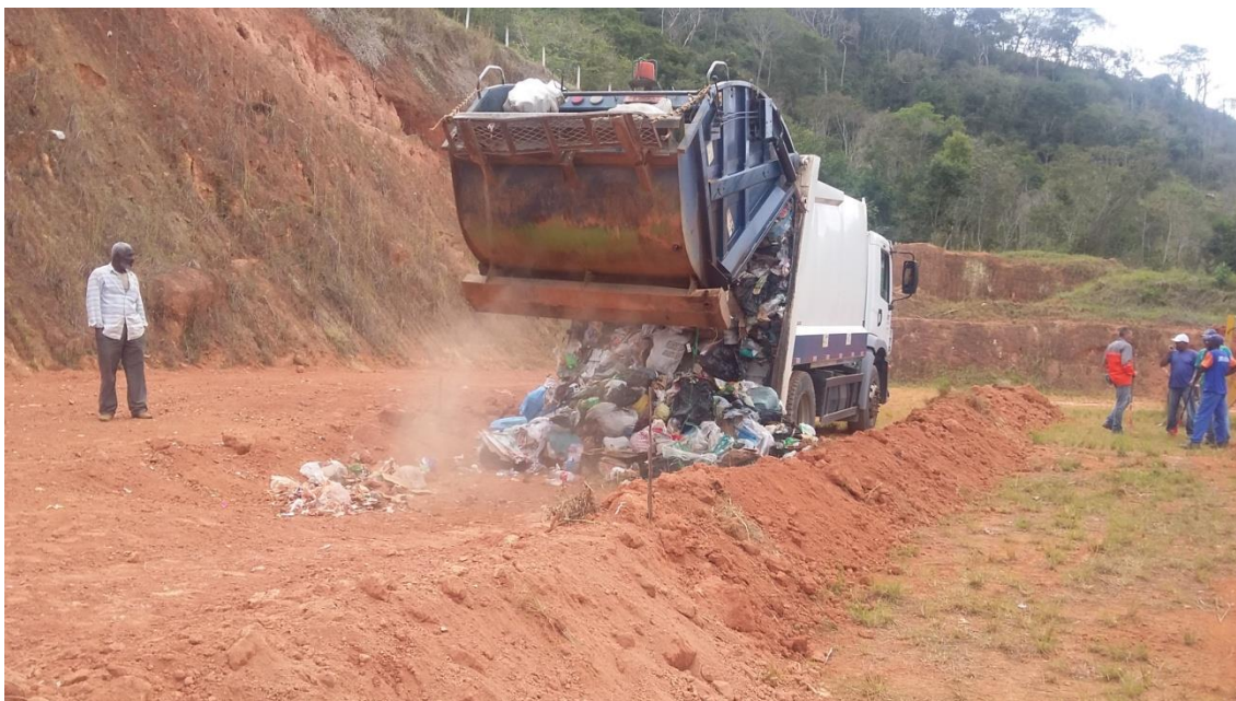
Figura 21: Disposição do lixo pelo caminhão coletor dentro da célula de recepção.
