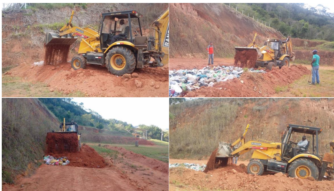
Figura 24: Retroscavadeira cobrindo resíduos com barro.
