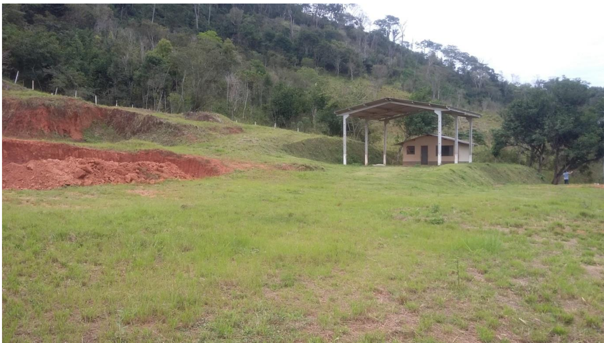
Figura 16: Galpão de triagem
