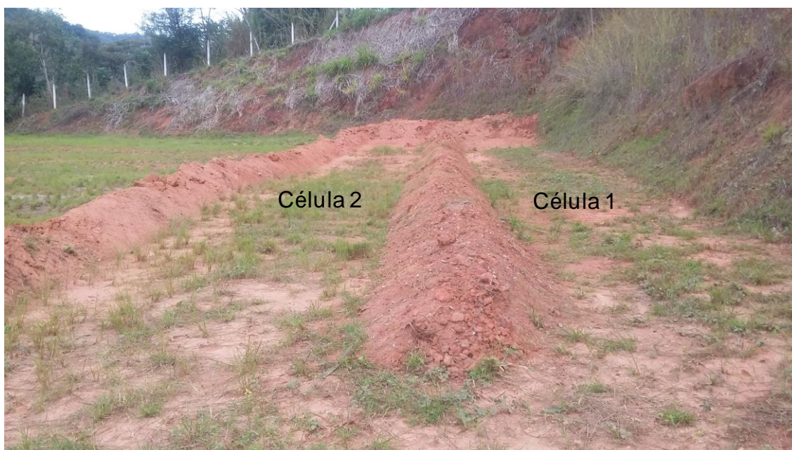
Figura 20: Primeiras células construídas para disposição final dos resíduos sólidos
