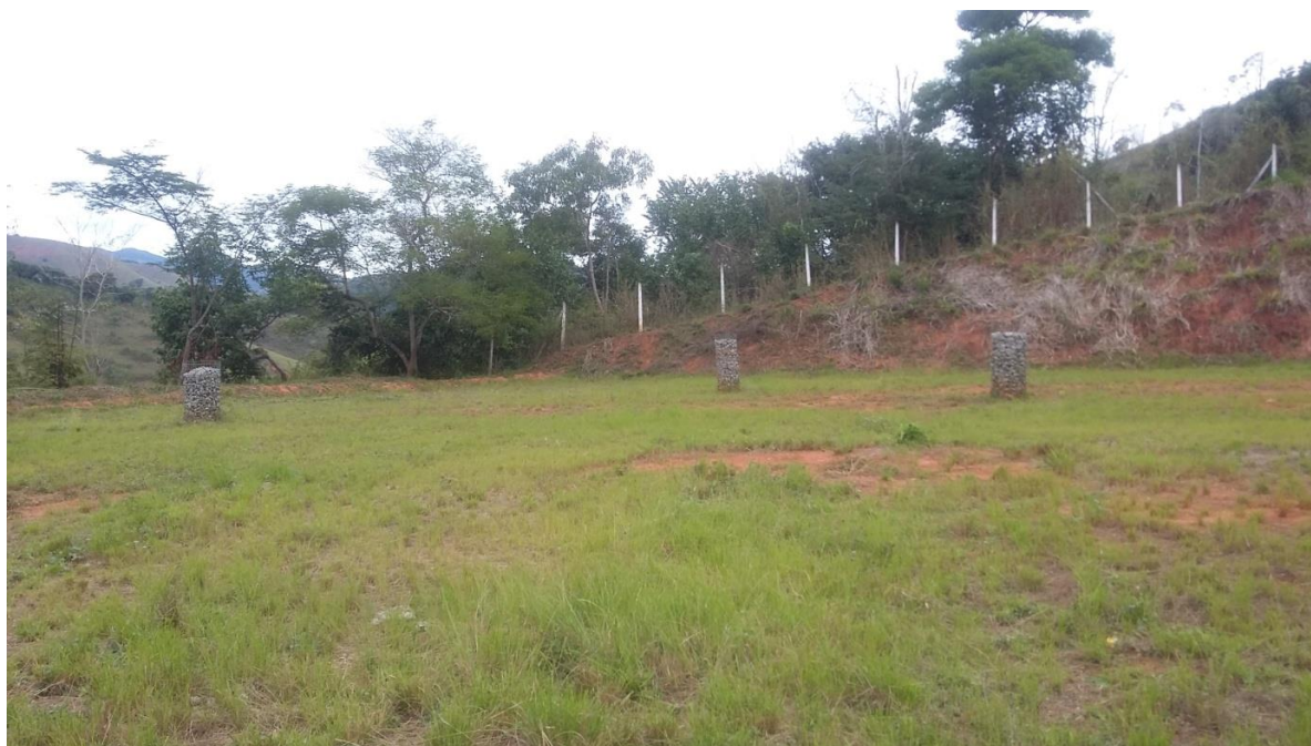
Figura 14: Área destinada à disposição final com drenos de gás.
