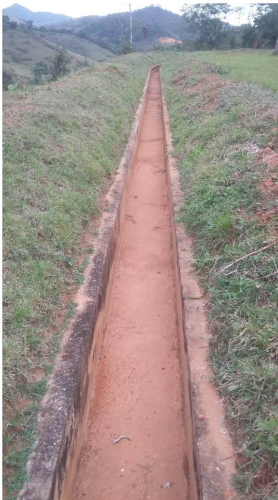
Figura 18: Canaleta para drenagem de águas pluviais.
