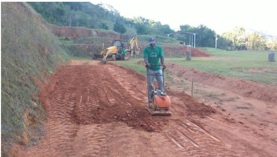
Figura 25: Compactação manual
