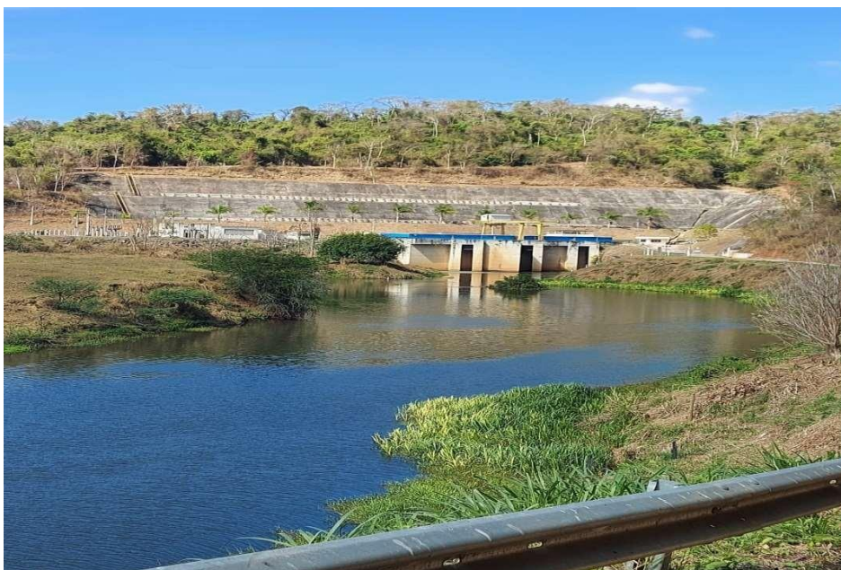
Figura 16: Casa de força da PCH Santa Rosa II.
