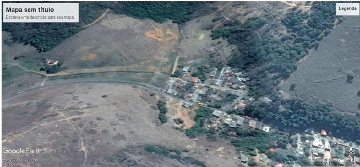
Figura 7: Bairro São José: R3 - Deslizamentos, escorregamentos e inundações.
