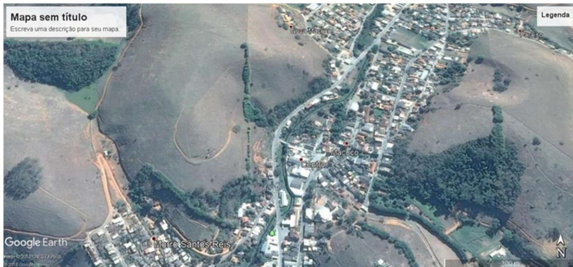
Figura 1: Bairro Centro: R3 – Enchente, inundações graduais, escorregamentos e deslizamentos.
